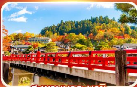
สะพานนากะบาชิ
