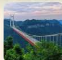
สะพานอ้ายจ้าย
